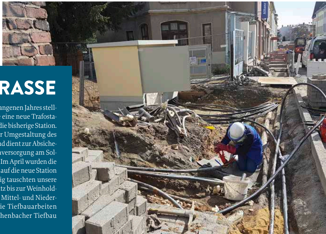
Die Monteure der Stadtwerke beim Abtrennen der alten Kabel (großes Foto) sowie beim Anbinden der Kabel an die neue Trafostation (kleines Foto).
