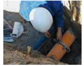
Auf der Friedensstraße werden der Abwasserkanal, die Trinkwasserleitung sowie das Strom- und Gasnetz erneuert.
