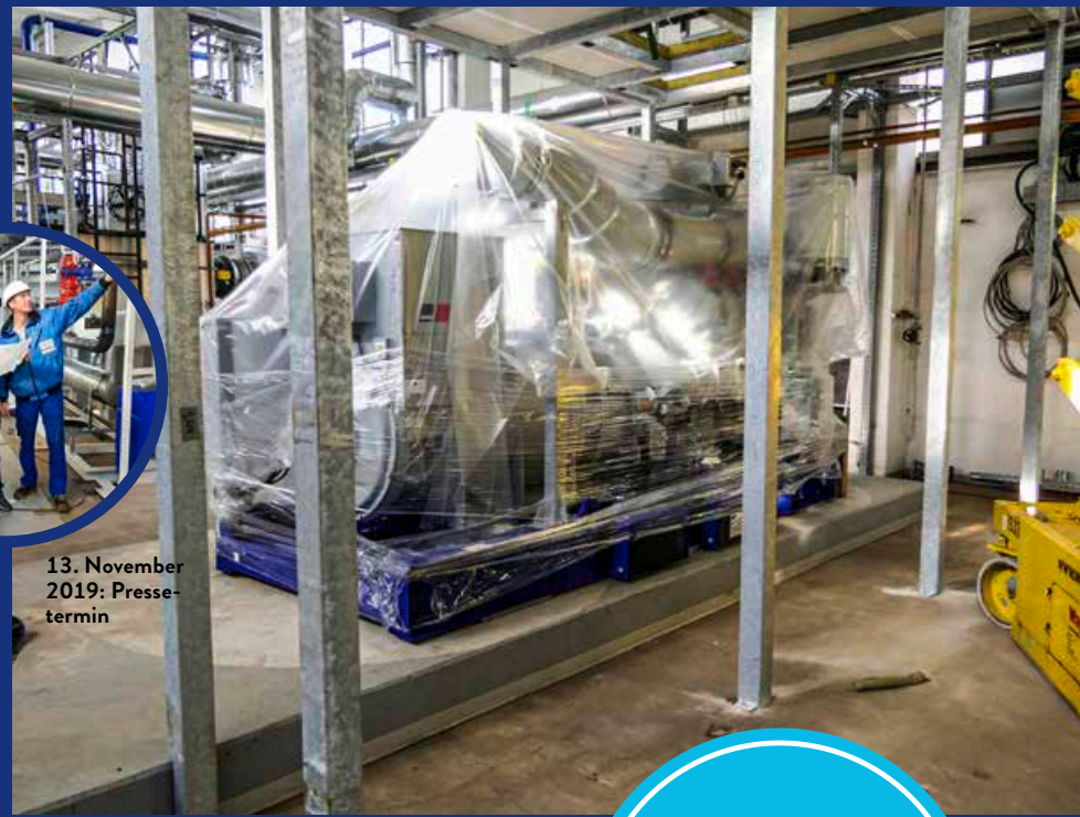
25. Oktober 2019: Das Biogas-BHKW ist platziert.
