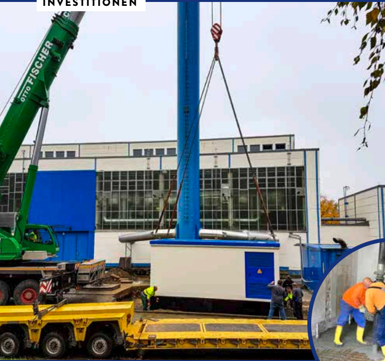
16. Oktober 2019: Anlieferung der neuen Trafostation
