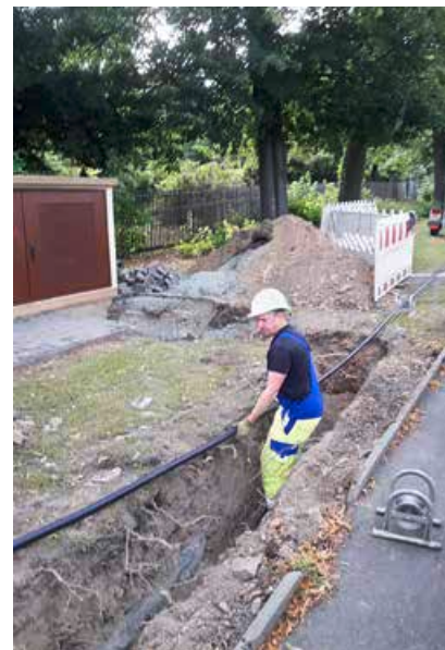
Mike Heydel beim Kabelzug
