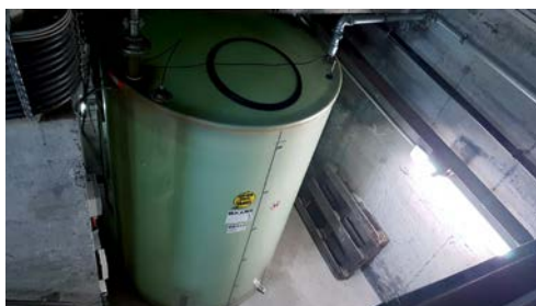
Links: Der montierte SCR-Katalysator auf dem Biogas-BHKW, rechts: der im Kellergeschoss eingebaute AdBlue-Tank
