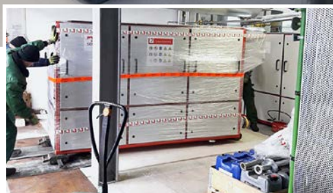
Ankunft und Installation des dritten Erdgas-BHKW
